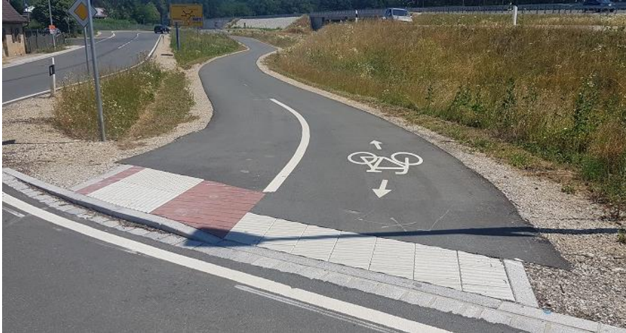
Abbildung 30: Sofern auf eine Materialkante nicht verzichtet werden kann, ist eine Kombination aus Nullabsenkung und Bordkante möglich. Die Absenkung sollte deutlich markiert und der gesamten Breite des kombinierten Geh- und Radwegs entsprechen. An der Querungsstelle für Blinde und Sehbehinderte sollte der Geh- und Radweg entsprechend aufgeweitet werden (abweichend vom Fotobeispiel).
