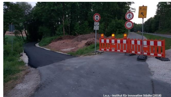
Abbildung 78: Asphaltierung einer beschilderten Umleitungsstrecke für den Radverkehr zur Gewährleistung der Alltagstauglichkeit
