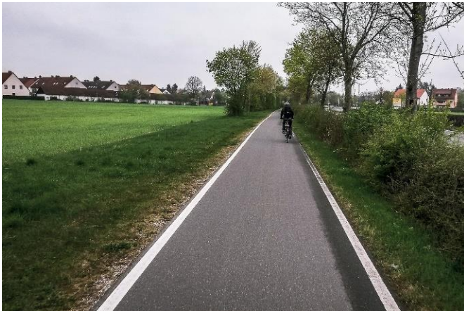
Abbildung 93: Weiße Randmarkierung auf einem außerörtlichen Radweg
