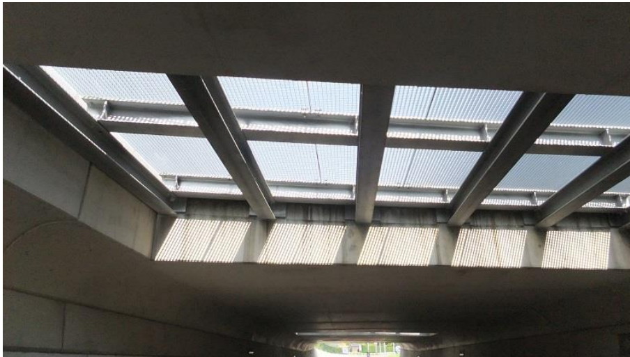
Abbildung 34: Beispiel für die bauliche Ausführung einer natürlichen Beleuchtung in einer Unterführung für den Radverkehr
