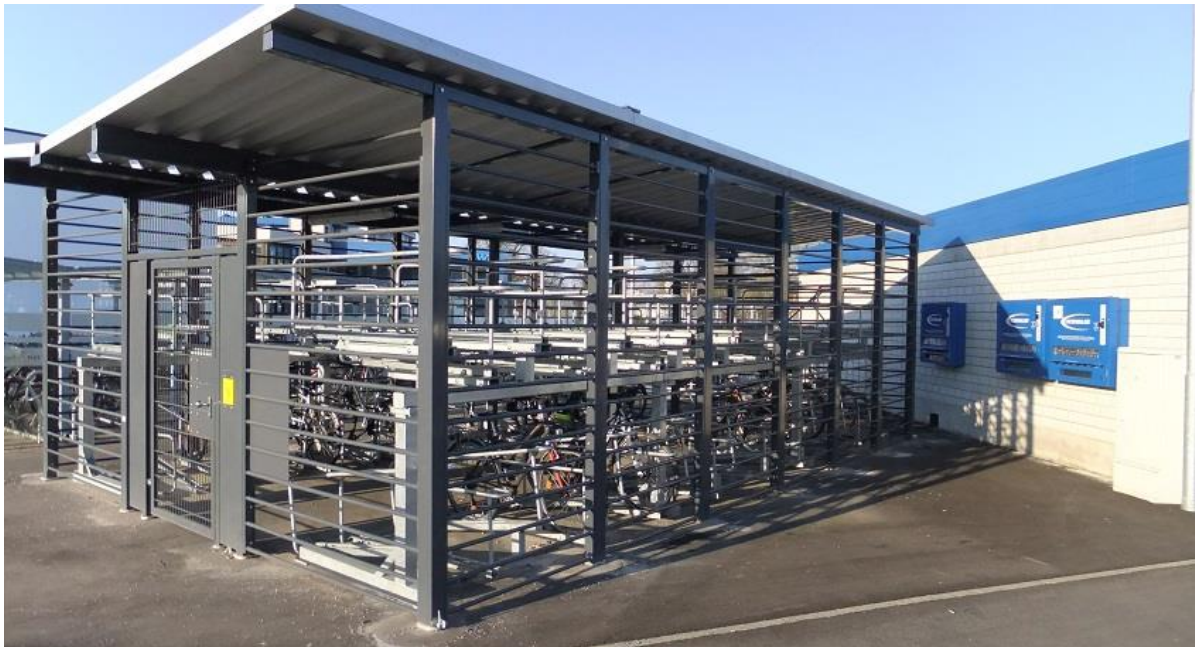
Abbildung 58: Sammelschließanlage mit elektronischer Zugangskontrolle
