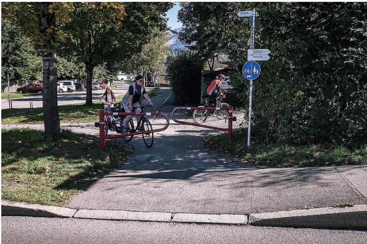
Abbildung 99: Umlaufsperrn als Hindernis
