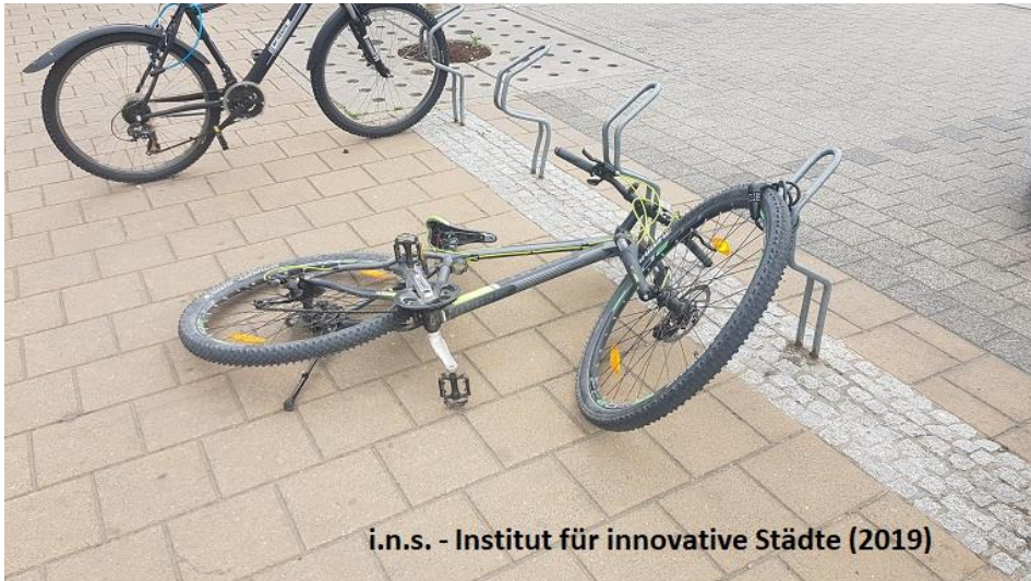
Abbildung 87: Veraltetes Abstellsystem ohne Kippschutz (sog. Felgenkiller).
