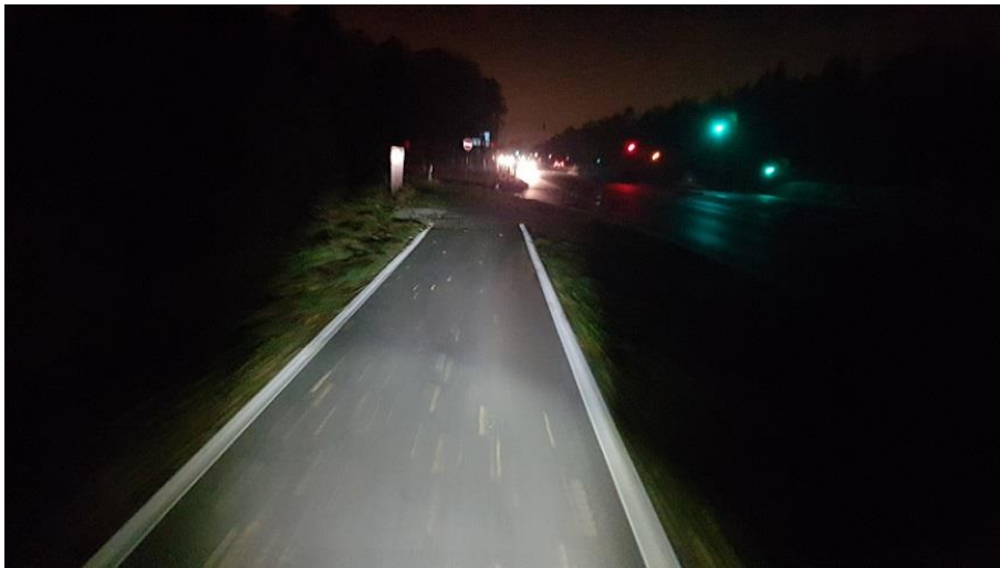
Abbildung 23: Eine weiße Randmarkierung erhöht die Erkennbarkeit der Verkehrsführung gerade bei Dunkelheit erheblich.
