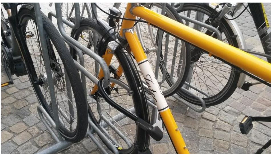
Abbildung 88: Ständer mit Kippschutz, aber zu kurzem Anschleißbügel. Der Fahrradrahmen kann mit einem herkömmlichen Schloss nicht angeschlossen werden.
