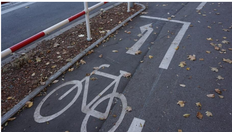
Abbildung 28: Induktionsschleife für den Radverkehr an einer Lichtsignalanlage
