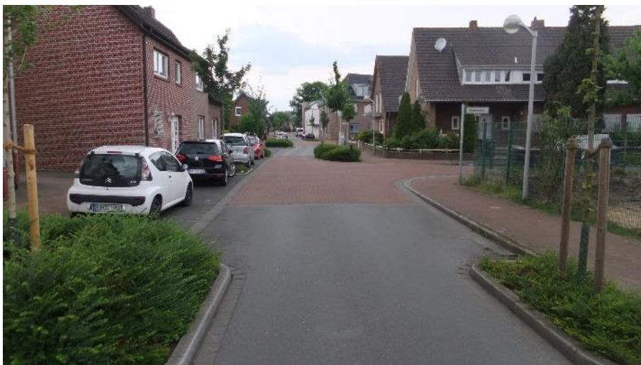
Abbildung 16: Mit Grüninseln werden in dieser Tempo-30-Zone eine Torsituation geschaffen und die Sichtachsen unterbrochen, so dass sich die Geschwindigkeiten reduzieren. Die Parkstände sind baulich ausgebildet und ordnen den Verkehrsraum. Im Einmündungsbereich erfolgt ein Materialwechsel von Asphalt auf Pflastersteine.
