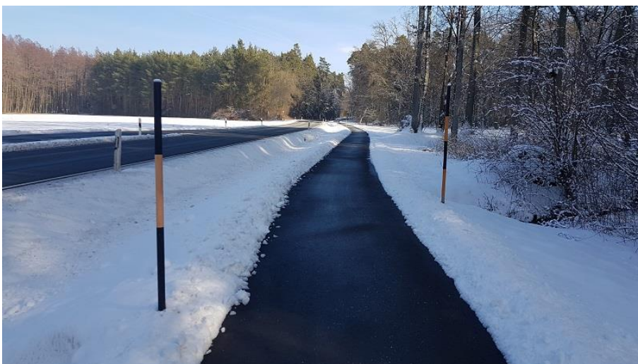
Abbildung 32: Schneestangen ermöglichen das sichere Befahren der Radwege auch im Winter – gerade auch außerhalb der Räumzeiten
