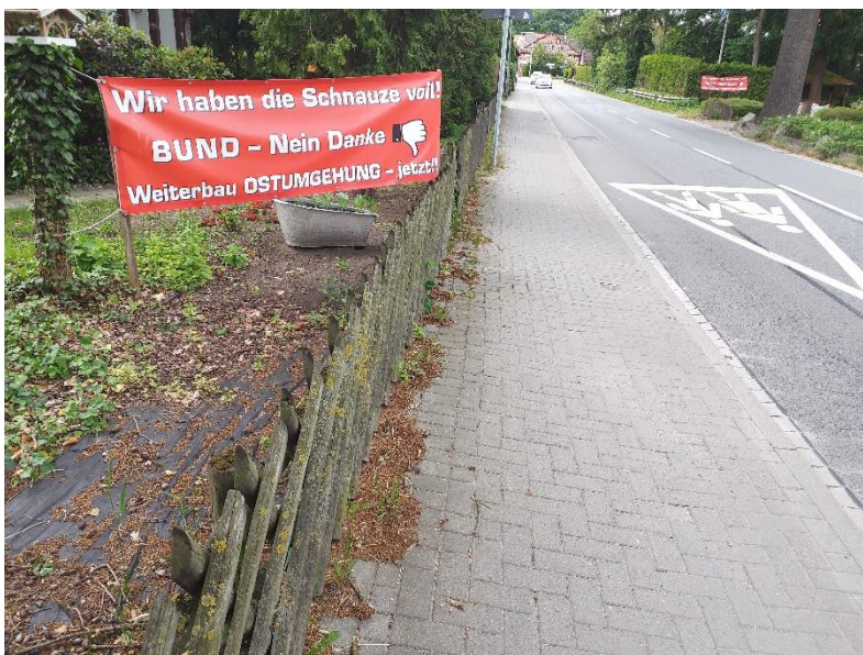
Abbildung 22: Die Radverkehrsanlage ist nicht als solche erkennbar.
