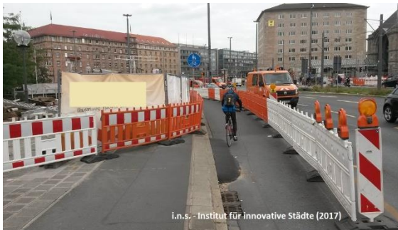
Abbildung 77: Fortsetzung der Radverkehrsführung im Baustellenbereich und Verwendung eines Asphaltkeils zum Überfahren des Hochbords
