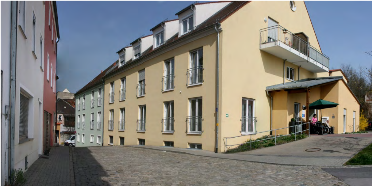
Abb. 61 Blick auf das Seniorenzentrum "Bühler Höhe" der Diakonie in der Bühlgasse 5 (u.m.s. GmbH)
