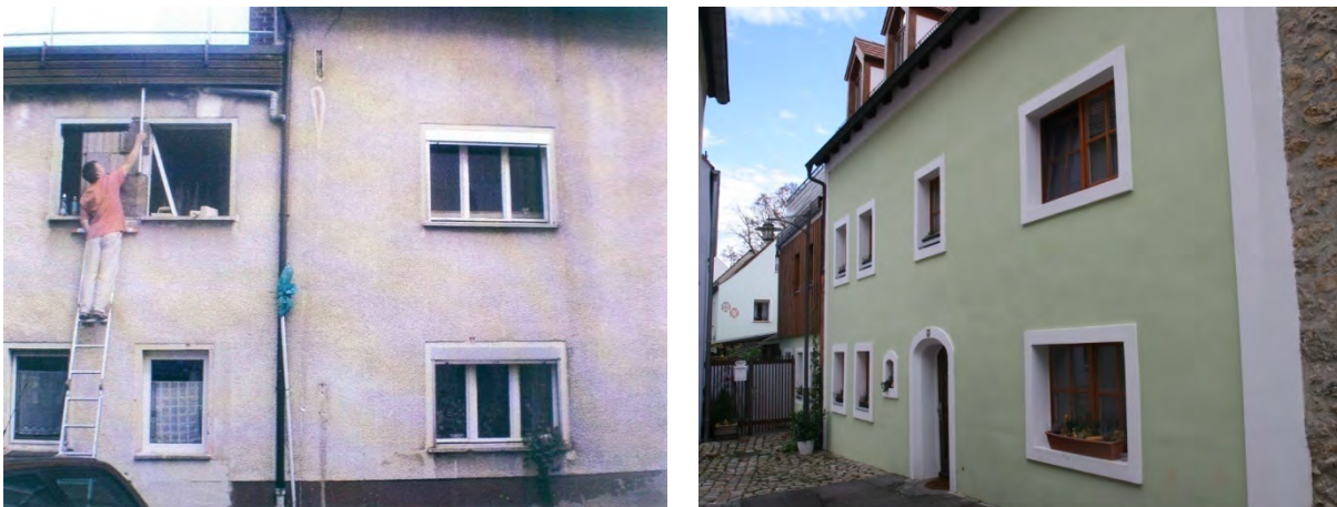
Abb. 32 Die Lange Gasse 5 vor (li.) und nach (re.) der Sanierung mit Unterstützung des kommunalen Förderprogramms (Stadt Sulzbach-Rosenberg, u.m.s. GmbH)
