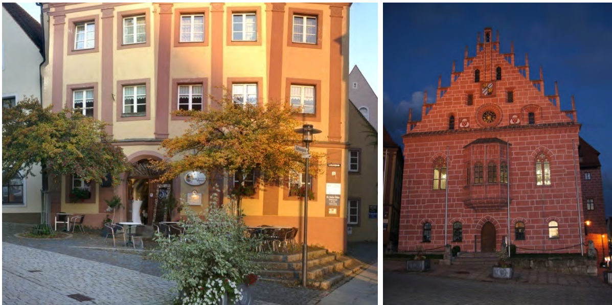
Abb. 27 In guter Gesellschaft – das mit Unterstützung des Bayerischen Städtebauförderungsprogramms sanierte Gebäude Luitpoldplatz 24 (li.) und das mit EFRE-Mitteln sanierte öffentliche Rathaus (re.) (u.m.s. GmbH)
