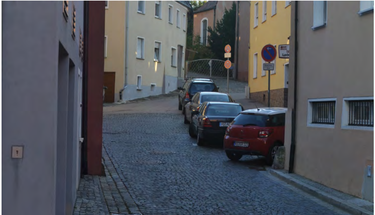
Abb. 75 Erschwerte Bedingungen für Menschen mit Gehbehinderungen durch Straßenprofil und Belagszustand in der Spitalgasse auf der Achse Seniorenheim "Bühler Höhe" – Rosenberger Straße (u.m.s. GmbH)
