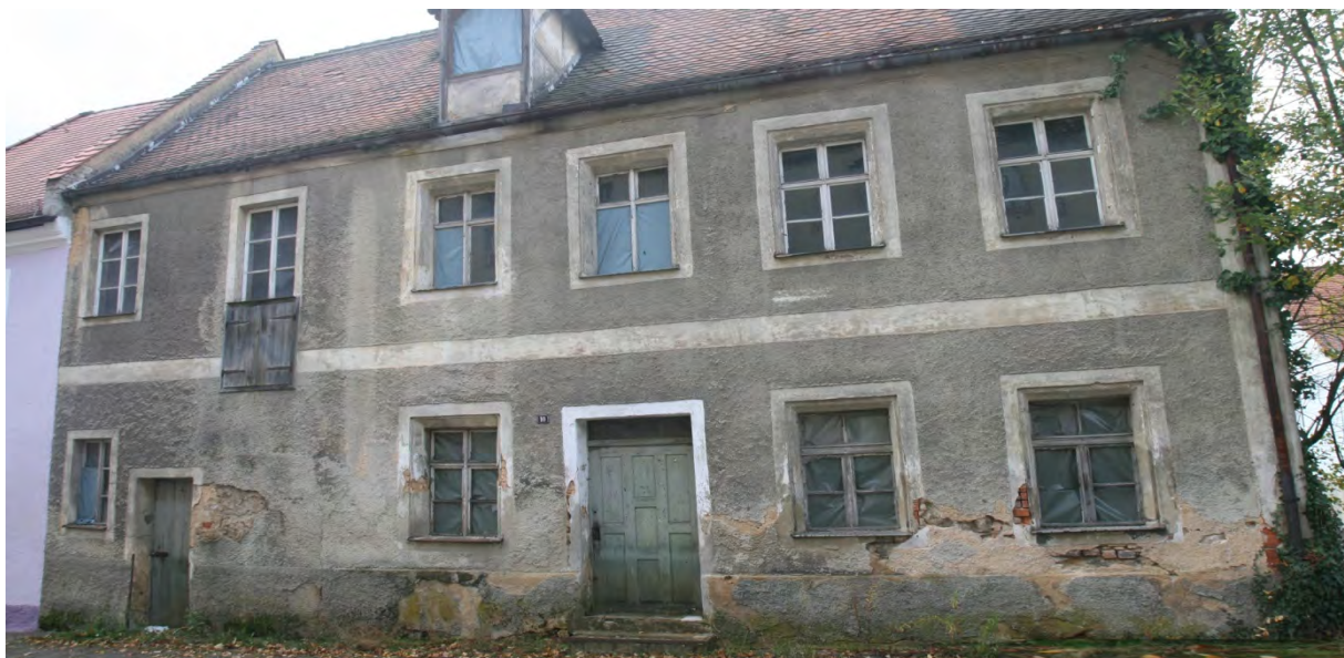
Abb. 36 Die Brauhausgasse 10 als eines der Gebäude der unteren Altstadt mit dem größten Sanierungstau (u.m.s. GmbH)
