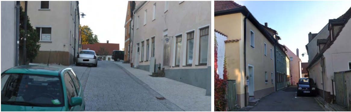
Abb. 58 Gehwege in der Neutorgasse - abgetrennt durch eine Wasserrinne niveaugleich mit der Fahrbahn (li), gemischte Verkehrsfläche in der Langen Gasse (u.m.s. GmbH)
