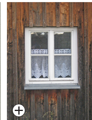
Sachgerechtes weißes Holzfenster in einem Nebengebäude
