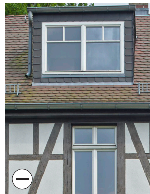
Ungeeignet: breit lagernde Gaube mit zwei Flügeln
