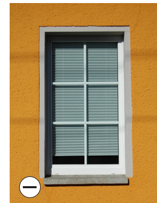
Ungeeignet: Schmale Putzfaschen und Kunststofffenster
