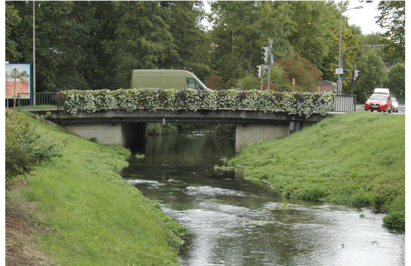
Brücke über den Rosenbach zur Erzhausstraße
