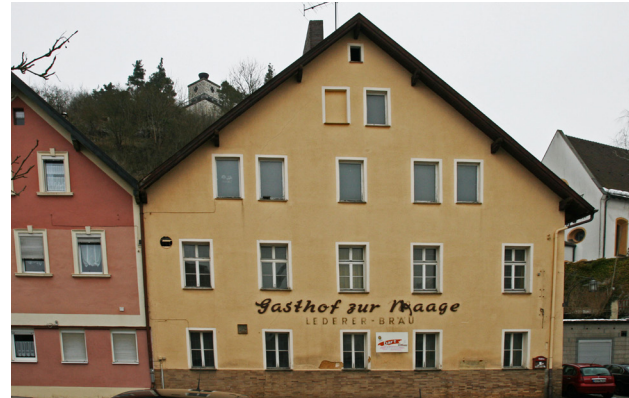
Lochfassaden an der Hauptstraße in Rosenberg: Die Fensterflächen ordnen sich den geputzten Außenwänden unter.
