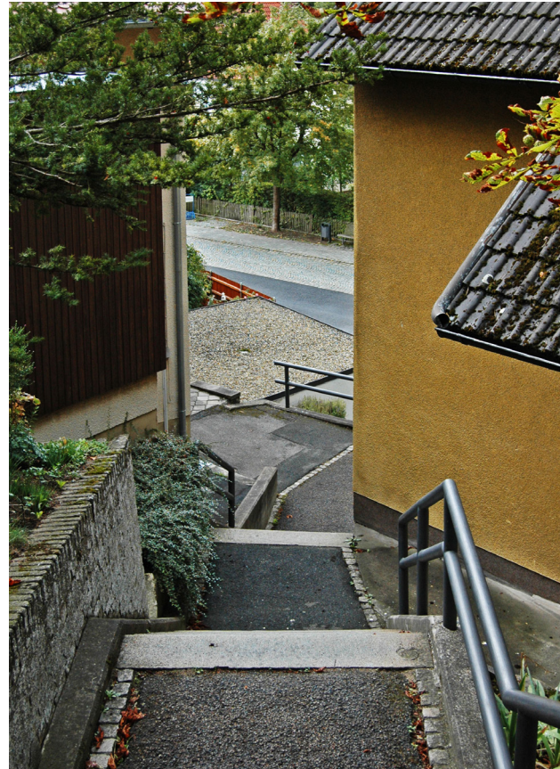
Treppenanlagen und rampenförmige Straßen sind typisch am Schlossberg. Sie erfordern Brüstungen und Geländer.
