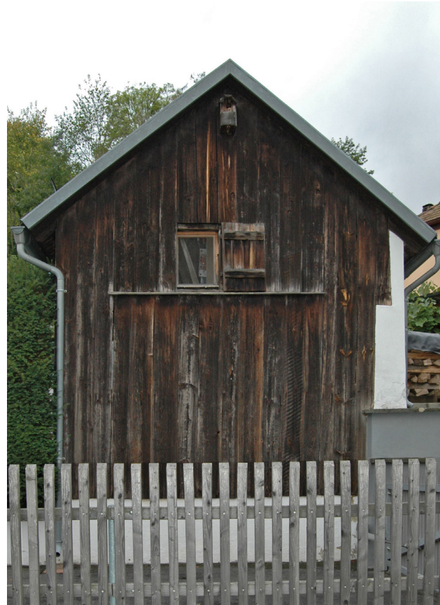
Typische Zauneinfriedung mit senkrechter hölzerner Lattung auf Holzriegeln passend zum hölzernen Nebengebäude
