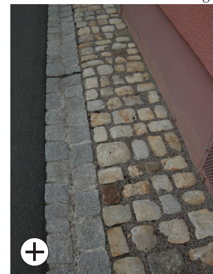
Beispiel für die Randfassung eines asphaltierten Fahrwegs
