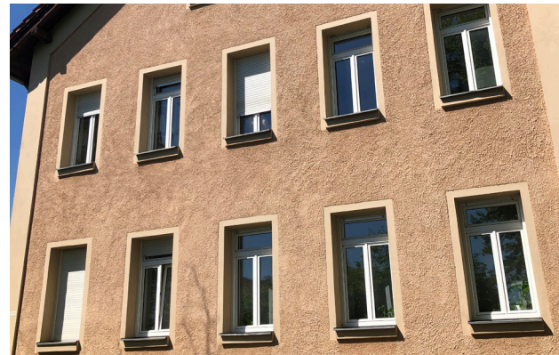
Beispiel für eine gut proportionierte Lochfassade mit breiten Faschen und gegliederten Fenstern
