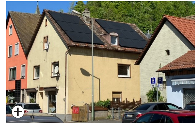
Geeignet: Solaranlage auf Dach
