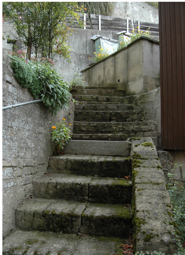
Treppenanlagen überwinden in gebrochener Linienführung den Höhenunterschied zwischen westlichem Schlossberg und Hauptstraße
