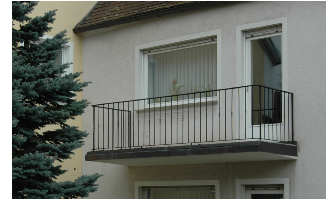
Balkongitter aus senkrecht angeordneten Profilstäben. Die schlichte Gestaltung ist geeignet für Neubauten.
