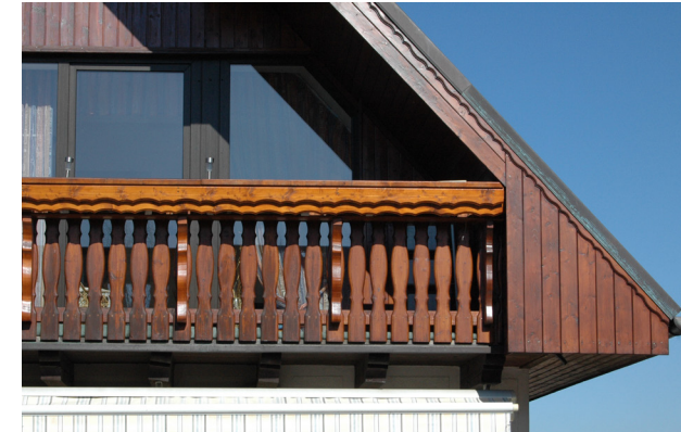
Ungeeignet: Folkloristisch profilierte Balkonbrüstung aus Holz, die senkrechte Gliederung ist sachgerecht.
