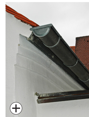
Metalldachrinnen und Abdeckbleche in mattierter Ausführung
