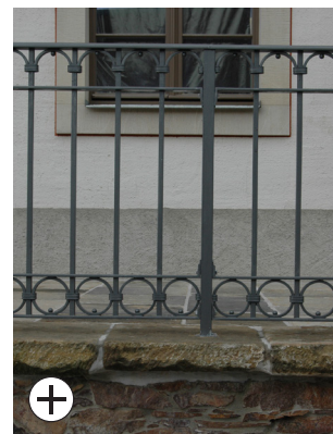
Sachgerechtes Brüstungsgitter in historischem Stil
