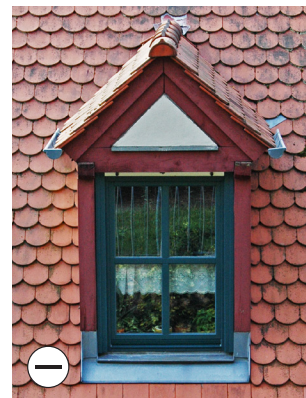
Satteldachgaube mit ungeeignetem Oberlicht
