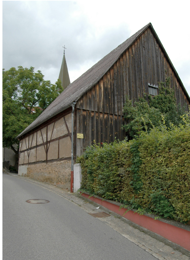
Nebengebäude in Fachwerkbauweise an der Hennebergstraße. Das Wegegefälle wird mit dem hohen Mauerwerksockel ausgeglichen.
