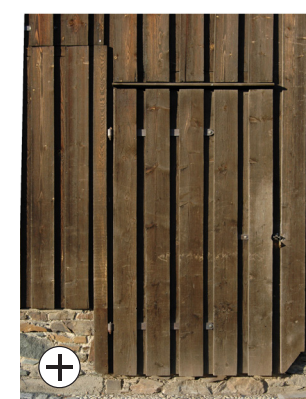
Sachgerechte Außenwand eines Nebengebäudes
