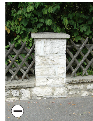
Ungeeignet: Hölzerner Jägerzaun als Einfriedung
