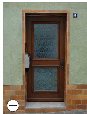
Ungeeignet: Umflieste Haustür mit großen Lichtausschnitten
