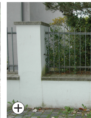
Gitter aus Profilstahl mit senkrechten Stäben
