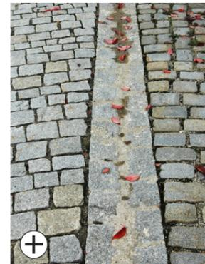
Verbindung von gepflastertem Schnittgerinne mit Pflasterfläche
