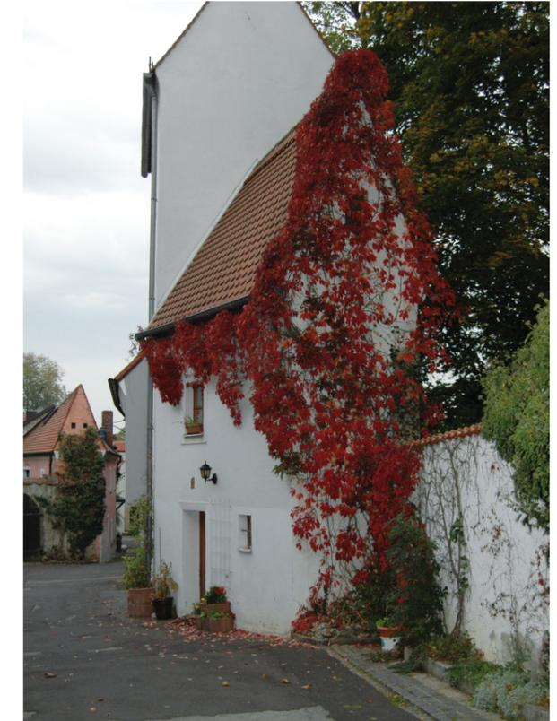
Einfriedung im Stadtmauerbereich. Geputztes Mauerwerk mit Abdeckung aus roten Biberschwanzziegeln
