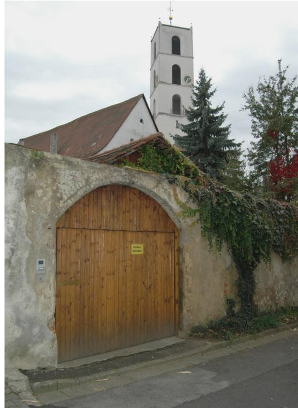
Sachgerecht: Grundstückseinfriedung aus geputztem Mauerwerk mit einem Zufahrtstor aus Holz mit senkrechter Verbretterung.
