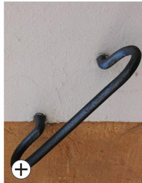
Handgriff aus Schmiedeeisen zur Sicherung einer Treppenanlage
