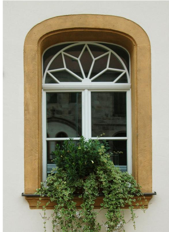
Vorbildlich saniertes Fenster mit ausgerundetem Sturz, Oberlicht und aufgehendem Stulp sowie schmalen Quer- und Ziersprossen
