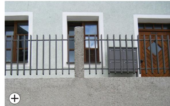
Geeignete Modernisierung mit Geländeranlage aus Profilstahl und gestocktem Sichtbeton
