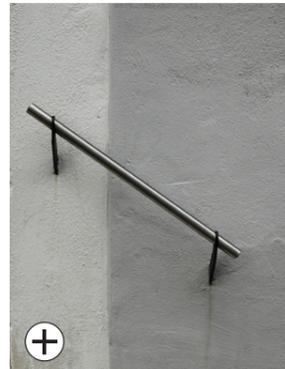
Handlauf aus Stahlrohr als Treppensicherung
