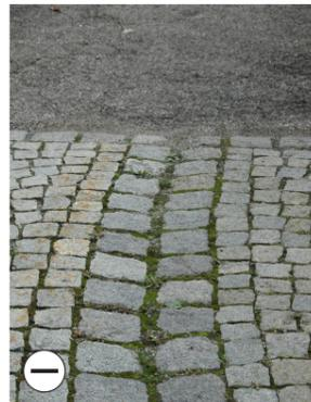
Fehlerhaft: Anbindung einer Asphaltdecke an ein Schnittgerinne
