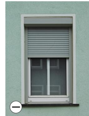
Ungeeignet: Von außen aufgesetzte Rollladenanlage
